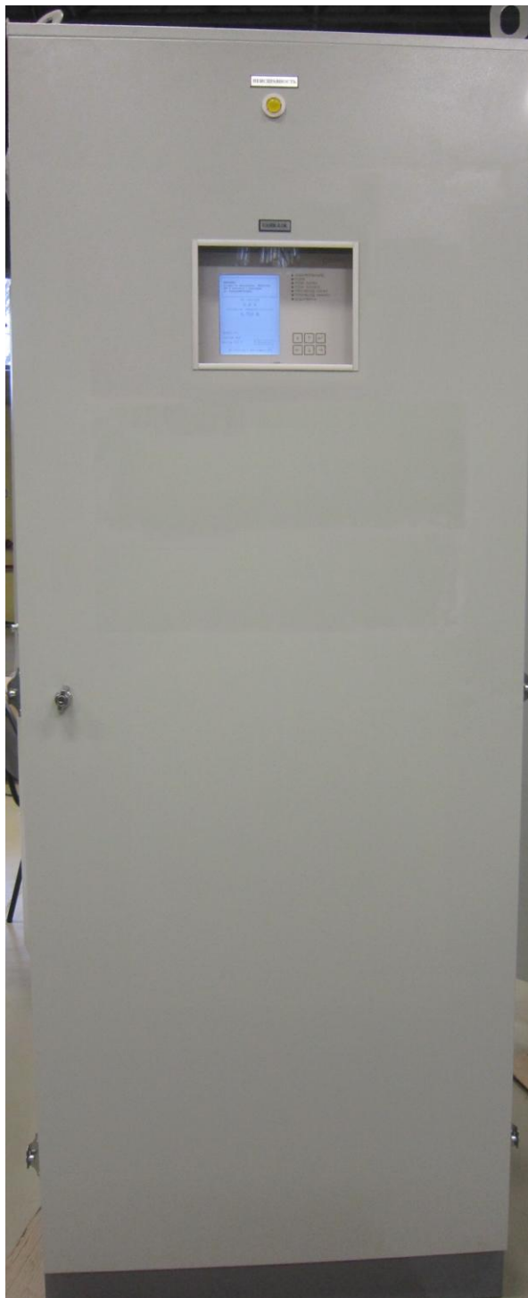
Рисунок 8 - Внешний вид шкафа СУРЗА.
